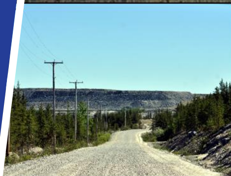
Ligne électrique de 60 km, routes du site et traversées de cours d'eau
