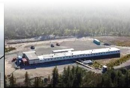
Camp de démarrage * fosse septique installée
